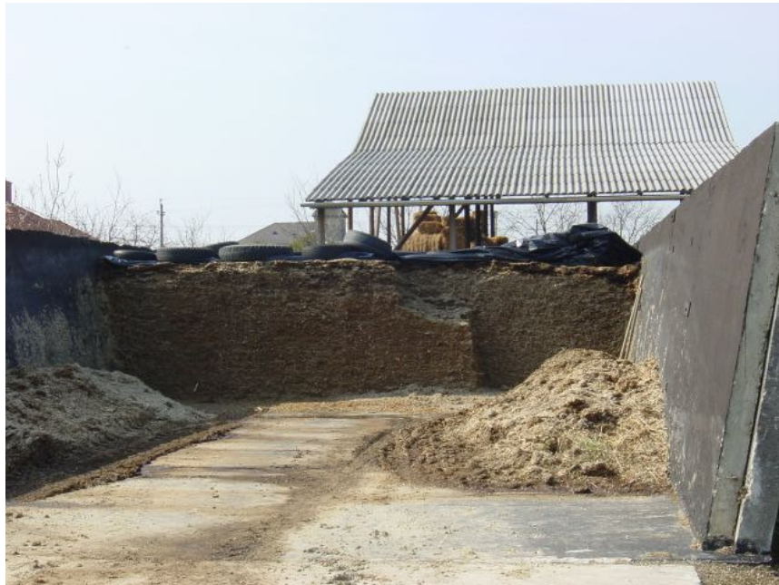
7. kép: A három oldalas silótér
