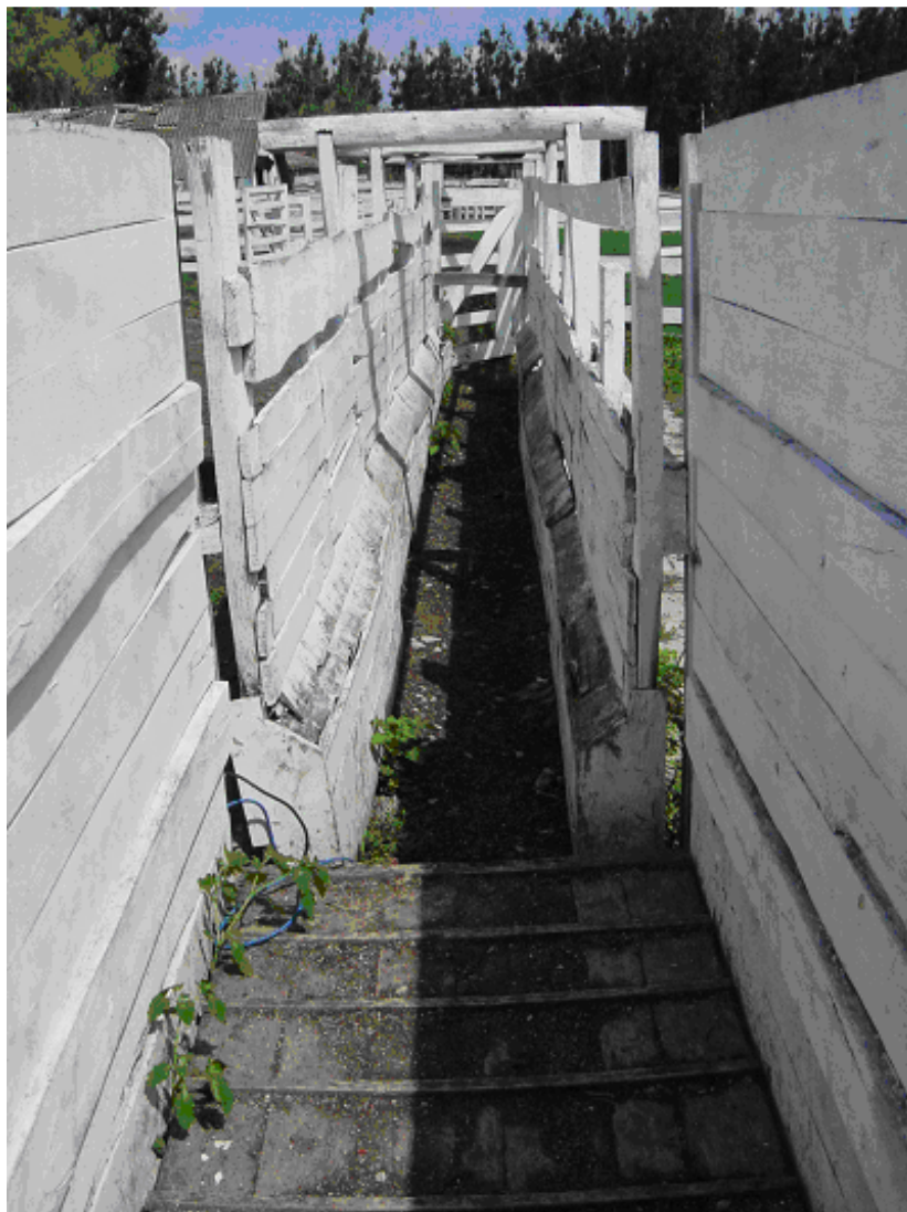
4. kép: A válogató-kezelő folyosó két belső oldala függőleges síkban lefelé szűkül, hogy a fiatal borjak ne fordulhassanak meg, és így azok is kezelhetők benne.
